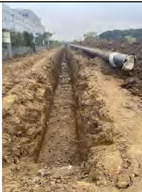
图 4.3 施工现场图片
